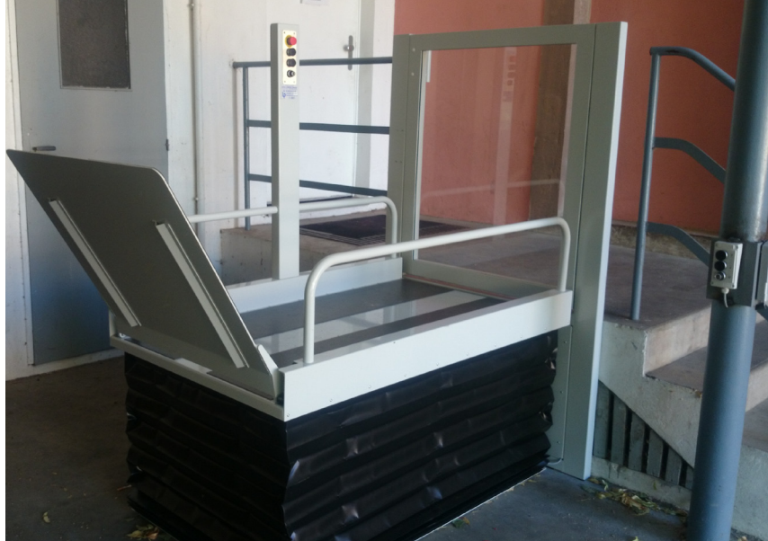
Rampe d'accès prolongée avec portillon supérieur et pilier de contrôle
