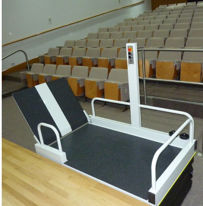
Accès latéral à l'arrêt supérieur et pilier de contrôle
