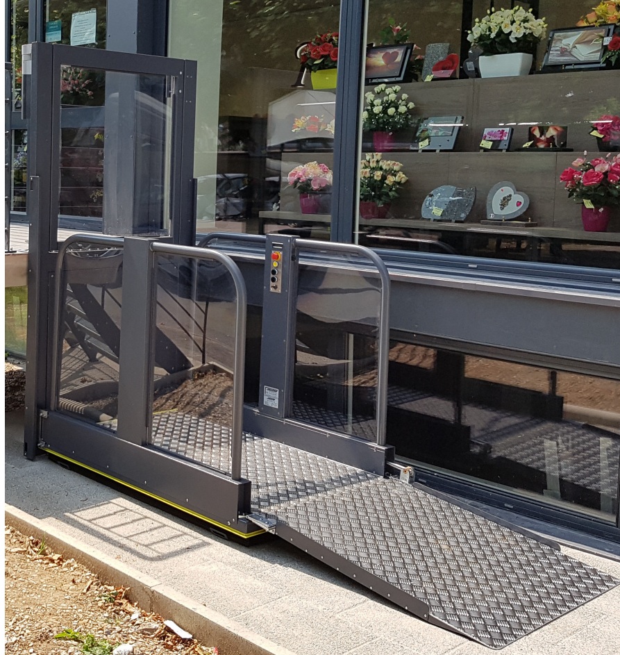
Plateforme élévatrice à ciseaux avec un minimum de hauteur de plateforme lorsqu'elle est abaissée
